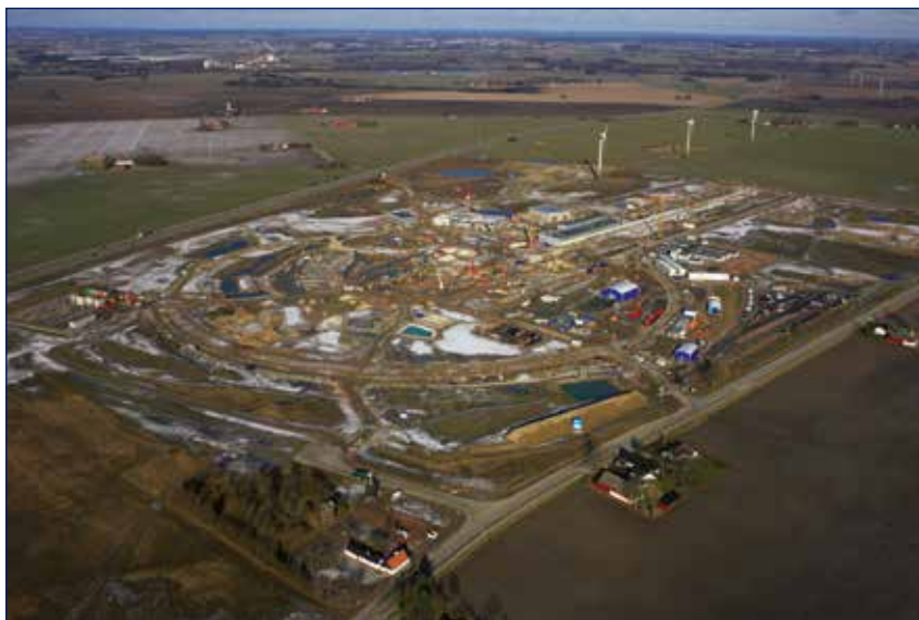
Obr. 1. Staveniště Evropského spalačního zdroje neutronů ve švédském Lundu v únoru 2016 (Zdroj: ESS).
